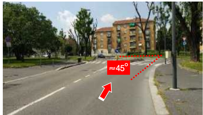
Figura 2.32 – Angolo di installazione dei radar rispetto alla direzione di marcia
